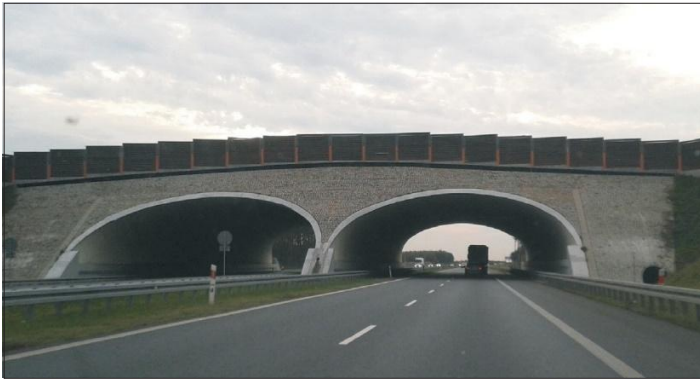
Мал. 1. Біопрехід з огорожувальною конструкцією з ґрунту на швидкісній автомагістралі S8 (фото В. Ясинського 2017).
